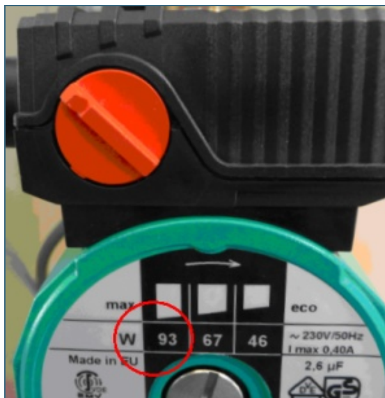
Abb. 1: An der abgebildeten Heizungsumwälzpumpe können drei Leistungsstufen eingestellt werden (roter Schalter). Eingestellt ist die Stufe 3, bei der die Leistungsaufnahme laut Typenschild 93 Watt (W) beträgt.
